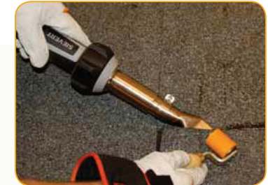
Bitumenschweißen
